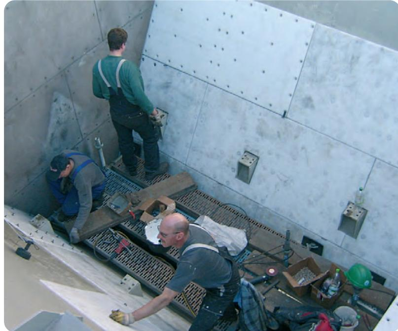
Bolzenschweißverfahren: Auskleidung eines Bunkers.
