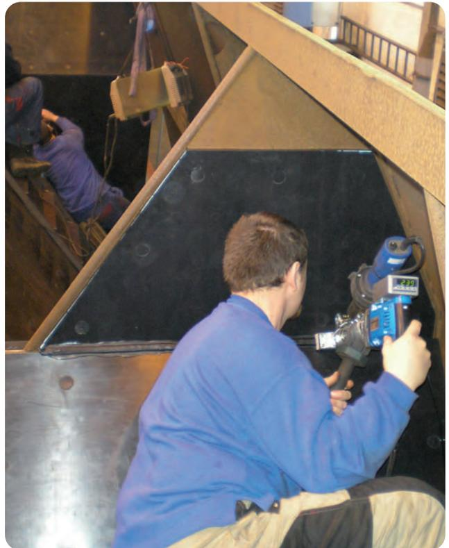
Schweißarbeiten beim Auskleiden eines Güterwaggonen: Die Matrox-Auskleidung wird an den angewinkelten Stoßkanten verschweißt um zu vermeiden, dass Schüttgut sich in den Winkeln festsetzt.
