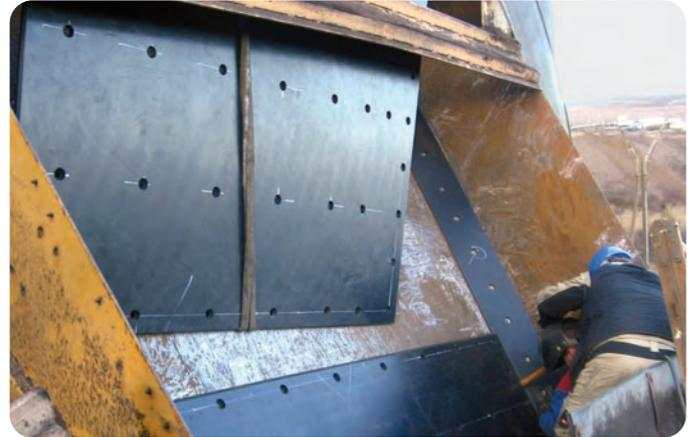
Antistatisch: Matrox EX 60 im explosionsgefährdeten Tagebau.
