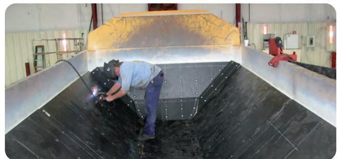
Fest verankert: Installation von Matrox-Platten in einem trichterförmigen Muldenkipper mit der Bolzenschweißtechnik.
