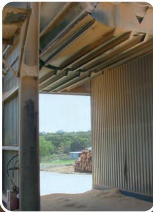
Blick von unten in einen Bunker: Bei großkörnigen Schüttgütern, die zu partiell starkem Verschleiß führen, können bereits Teilauskleidungen mit Matrox die Lebensdauer des Bunkers deutlich erhöhen.
