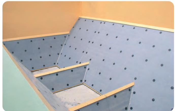
Bunkerauskleidung mit „Weld washern“:
